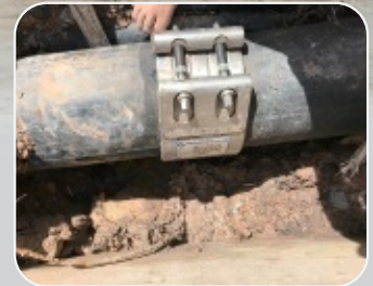
▶ PE Pipe Repair
